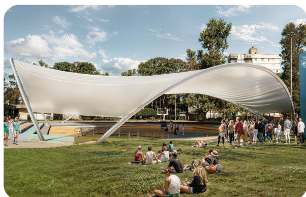
Cubierta Paseo XXI (Rosario)
